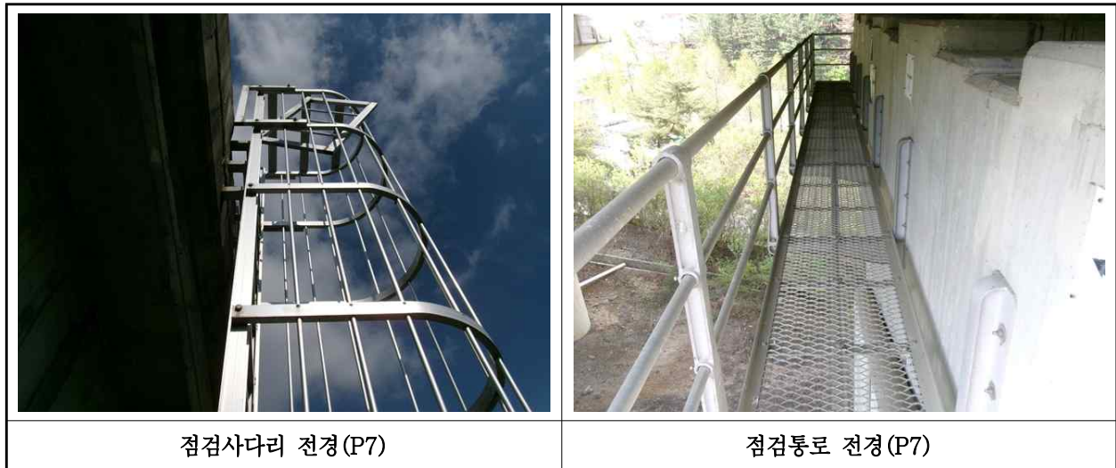
【사진 4.3.25】 교량 점검시설 전경
