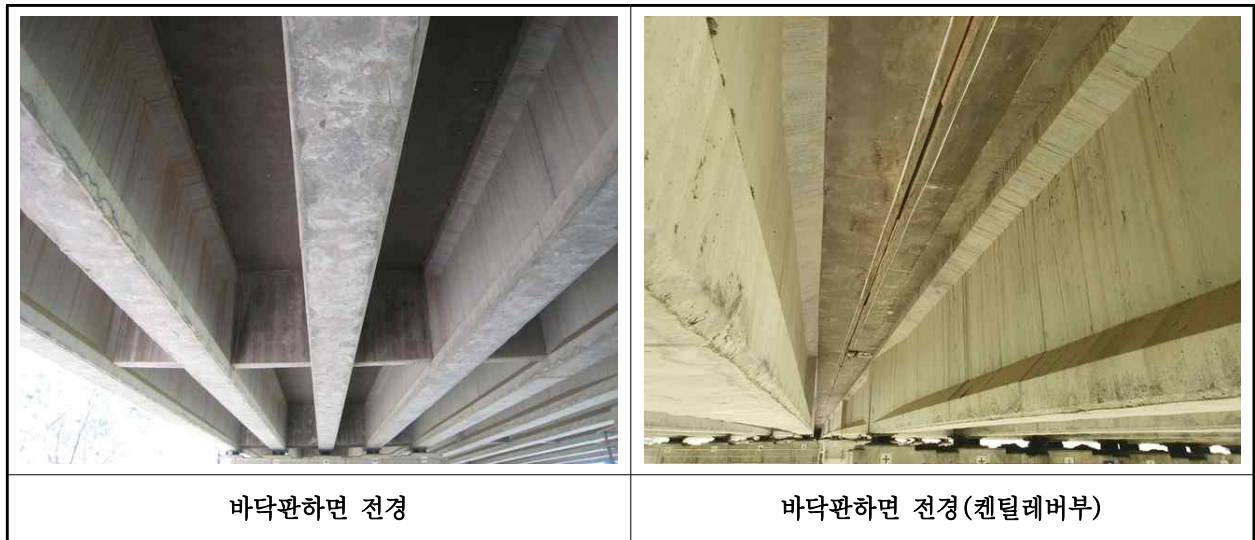
【사진 4.3.2】 바닥판하면 전경
