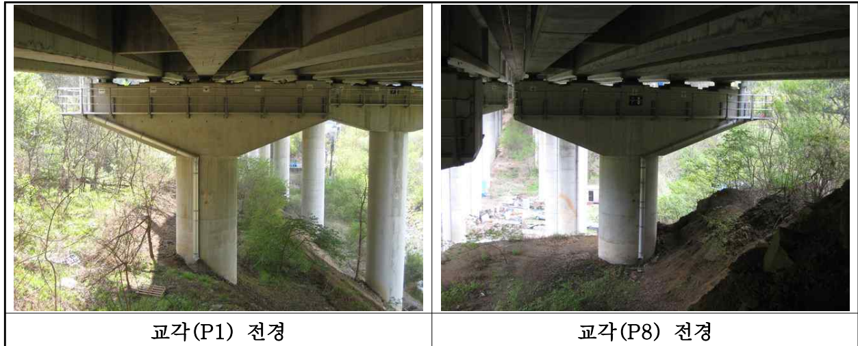
【사진 4.3.10】 교각 전경
