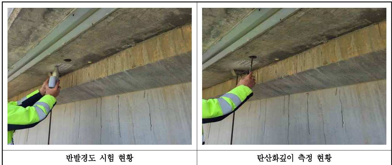
【사진 4.4.1】 콘크리트 내구성조사 현황
