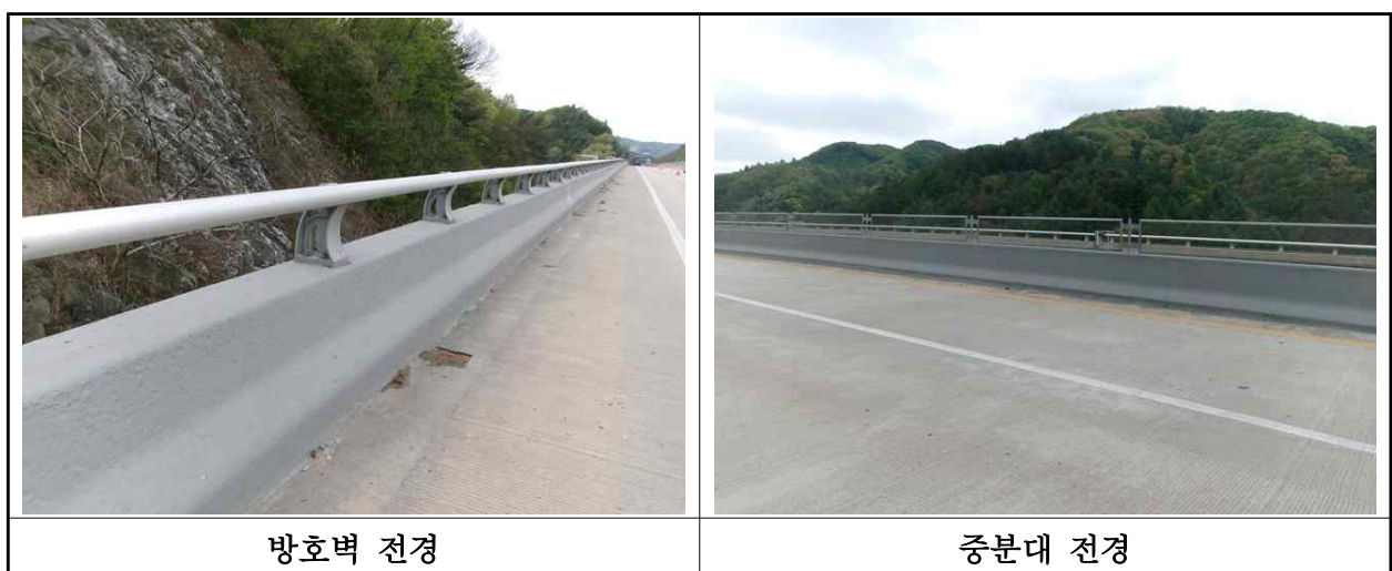
【사진 4.3.23】 방호벽 및 중앙분리대 전경
